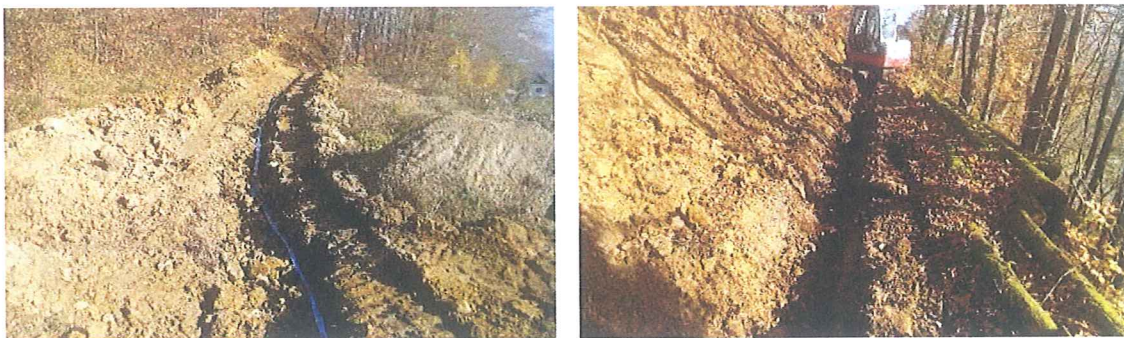
Slika 22: Izvedba vodovoda Dolenji Cirknik
