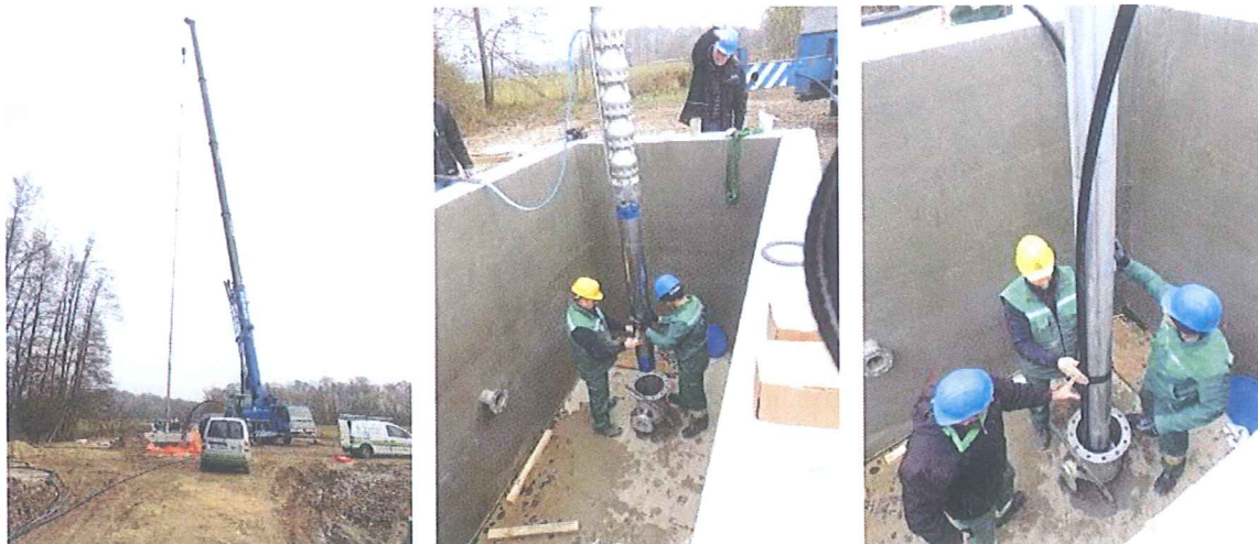
Slika 23: Črpalni jašek na vrtini Glogov Brod – vstavljanje črpalke
