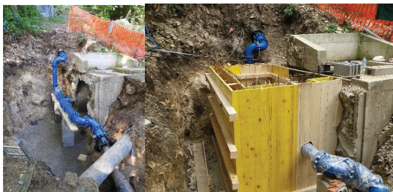
Slika 15: Izvedba jaška na VH Čatež
