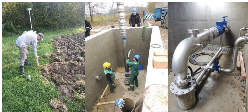
Slika 14: vgradnja črpalke na vrtini Glogov brod
