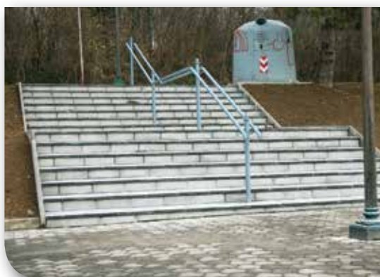
Sanirano glavno stopnišče.
