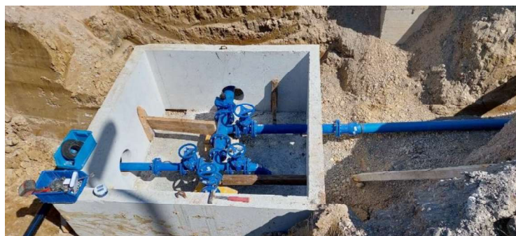
Slika 9: Izgradnja vodovoda Kera net – Gril
