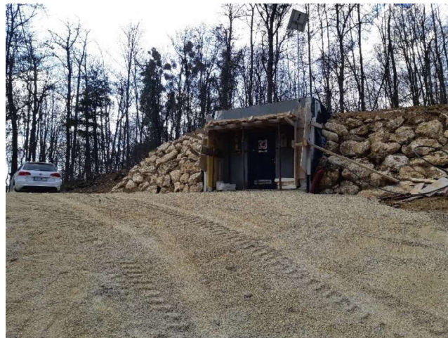
Slika 8: Obnova VH Velika Dolina
