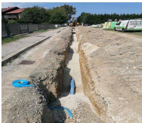
Slika 6: Izgradnja vodovoda Ulica Kozjanskih borcev
