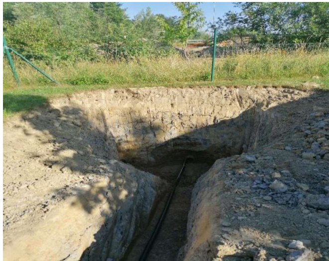
Slika 10: Tlačni vod kanalizacije Nova vas - Žaga
