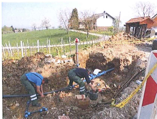
Slika 31: Izgradnja sekundarnih cevovodov Žejno-Straža-Mrzlava vas
