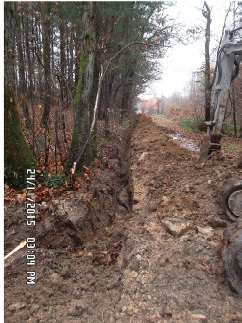
Slika 20: Obnova vodovoda PE 63 Rajec
