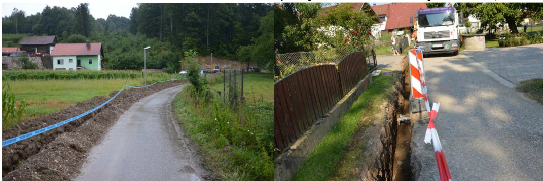
Slika 28: Obnova sekundarnih cevovodov in priključnih mest Gorenja Pirošica, izvedba
