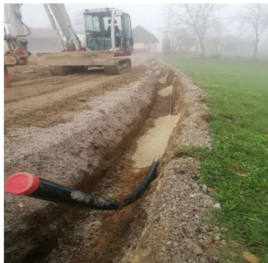
Slika 10: Obnova vodovoda Zakot
