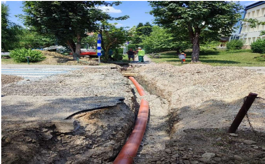
Slika 7: Obnova vodovoda Černlečeva cesta
