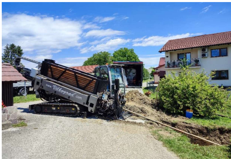
Slika 11: Obnova vodovoda Zgornji Obrež (Podvrtanje)
