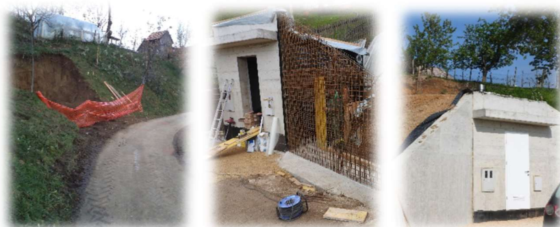
Slika 20: Izgradnja VH Cirnik
