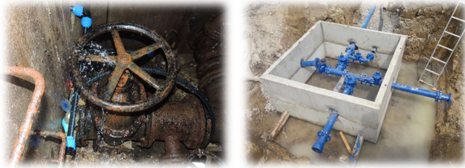
Slika 21: Izvedba jaška na Bizeljski cesti
