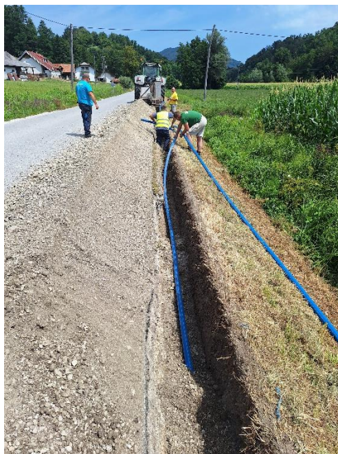
Slika 5: Obnova vodovoda Blatno
