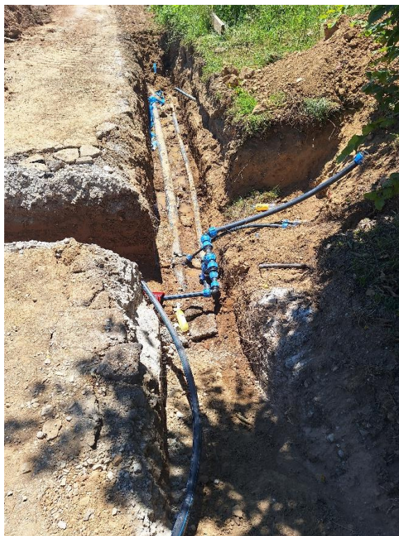
Slika 6: Obnova vodovoda Pišce
