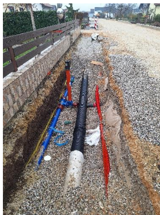
Slika 7: Obnova vodovoda – Cvetna ulica, Dobova
